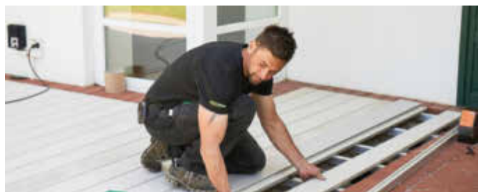
Zuerst ein Schotterbett, dann eine Unterkonstruktion, zum Schluss die WPC-Dielen: So baut man eine Terrasse fachgerecht auf. Foto: djd/NATURinFORM
